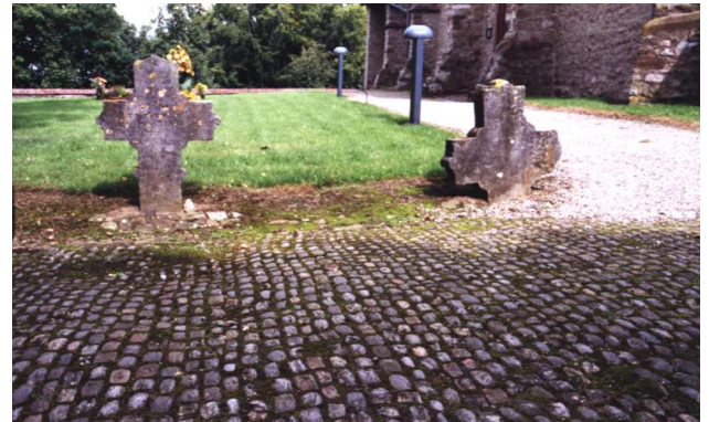
Abb.2: Pflaster aus Brennringen vor der „Alten Kirche“
