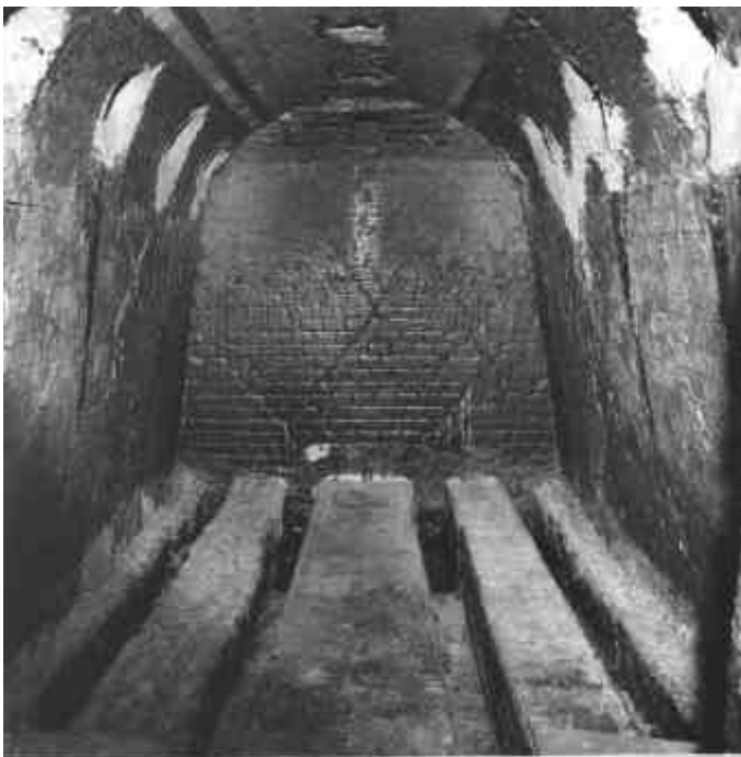
Abb. 6-11: Konstruktionszeichnung eines Raenerer Steinzeugofens aus dem Jahr 1877 (oben links), darunter Blick in einen Westwälder Ofen mit doppelter Feuerung (unten links). Rechte Spalte, v.o.n.u.: Konstruktionszeichnungen von Hubert Schiffer und Vikar J.P. Schmitz (19. Jh.) und Foto vom Salzen eines Westwälder Ofens.
